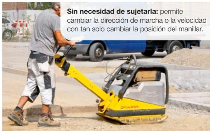
**Sin necesidad de sujetarla:** permite cambiar la dirección de marcha o la velocidad con tan solo cambiar la posición del manillar.
