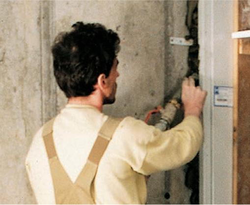
El llenado de marcos no supone ningún problema con la Sprayboy. Mediante un telemando permite conectarlo y desconectarlo con toda comodidad.
